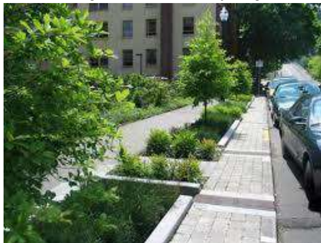
Figura 75: Vala de infiltração vegetada
