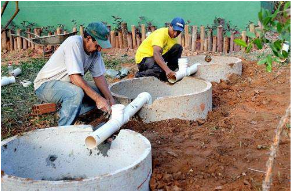
Figura 89: Fossas sépticas biodigestoras - montagem
