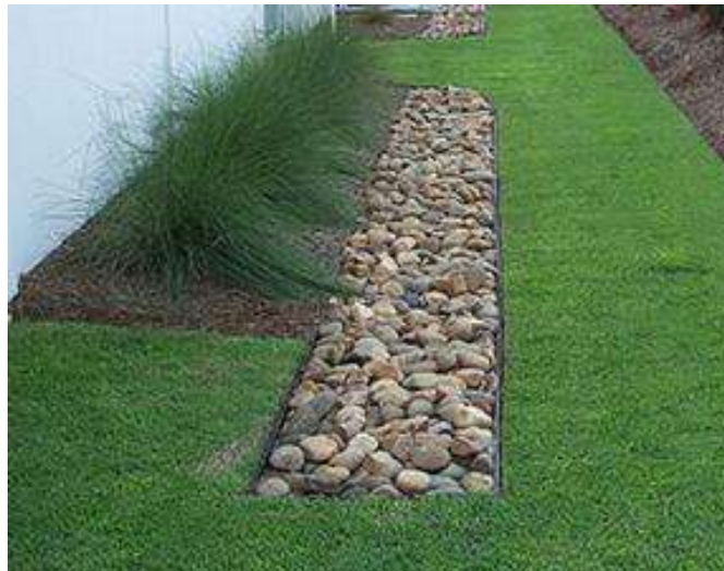
Figura 72: Modelo de trincheira de infiltração
