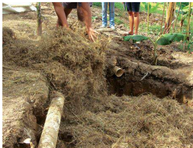
Figura 59: Preenchimento da vala com Capim Seco
