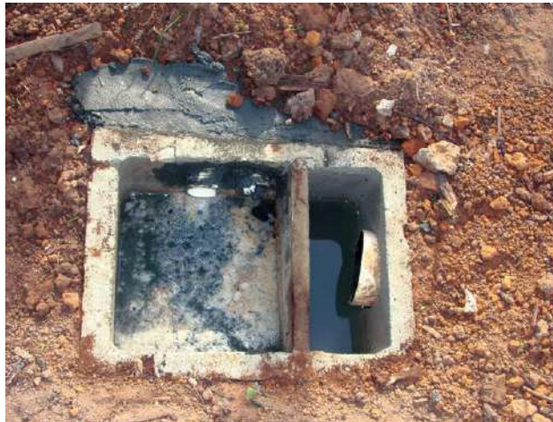
Figura 58: Caixa de gordura que vai para o Círculo de Bananeira
