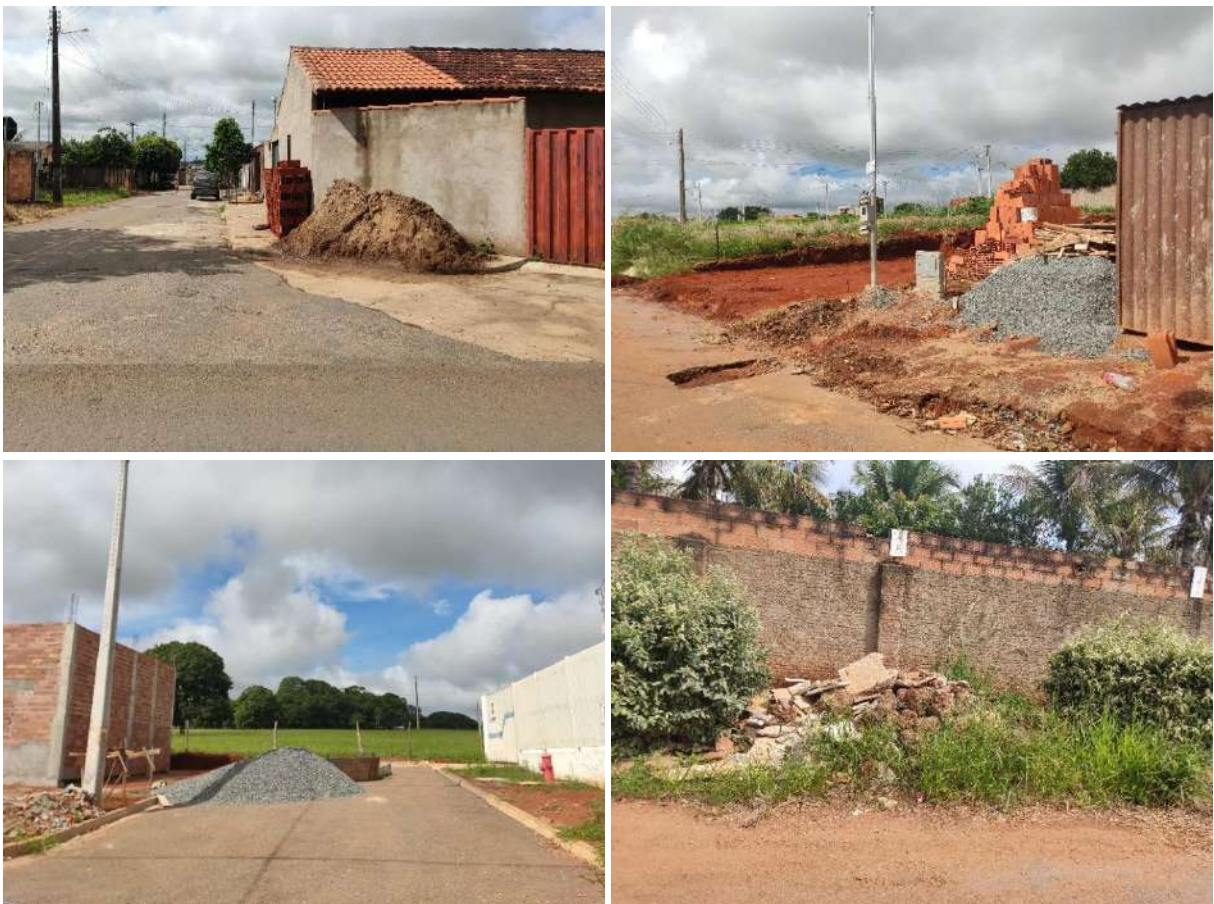
Figura 46: Resíduos de construção civil
