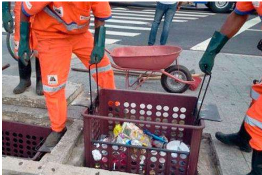
Figura 60: Caixa coletora instalada em bueiros
