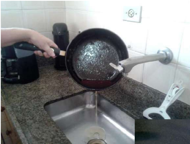
Figura 91: Descarte indevido de óleo ocasiona obstrução na rede
