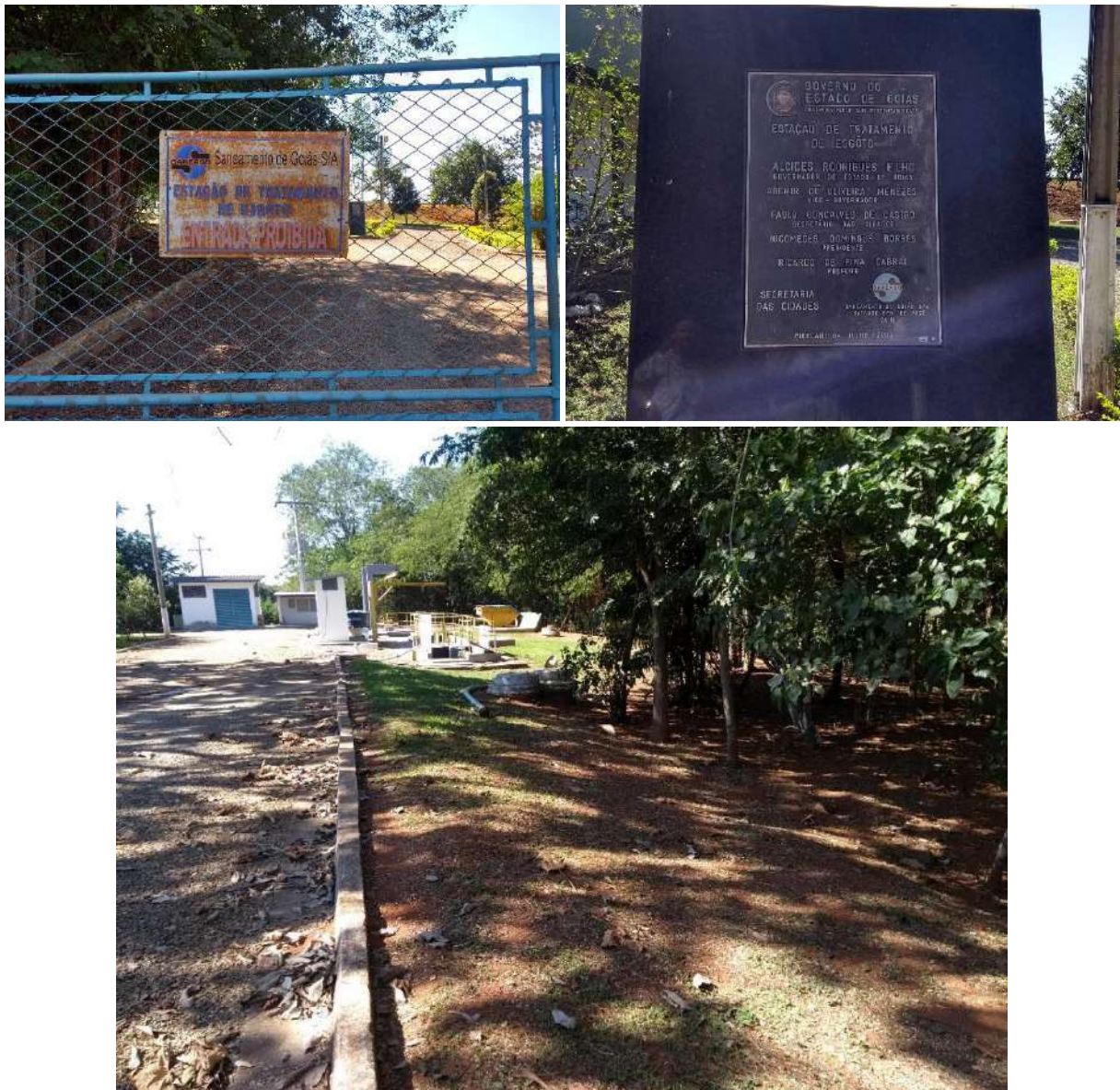
Figura 35: Estação de tratamento de esgoto
