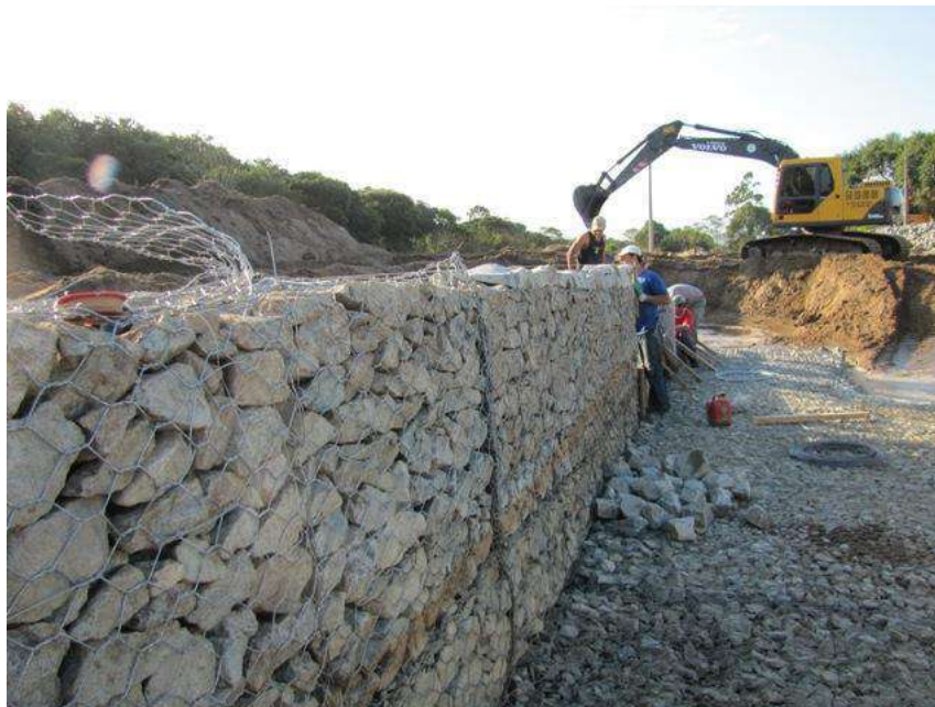
Figura 77: Tratamento de fundo de vale
