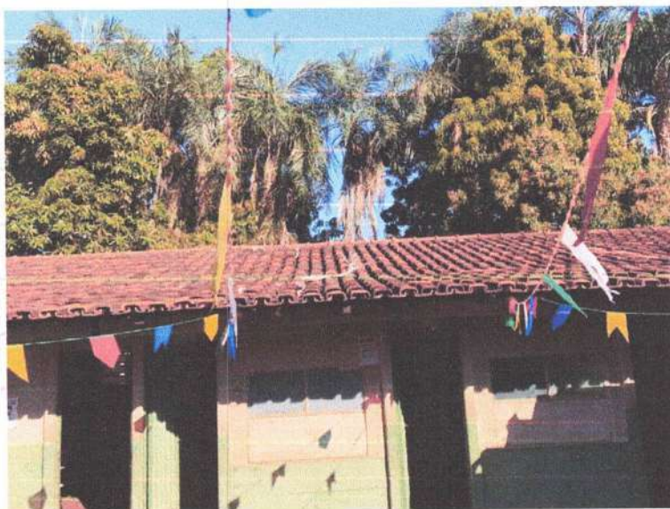
Figura 03 - Bloco 1 – Vista Lateral
