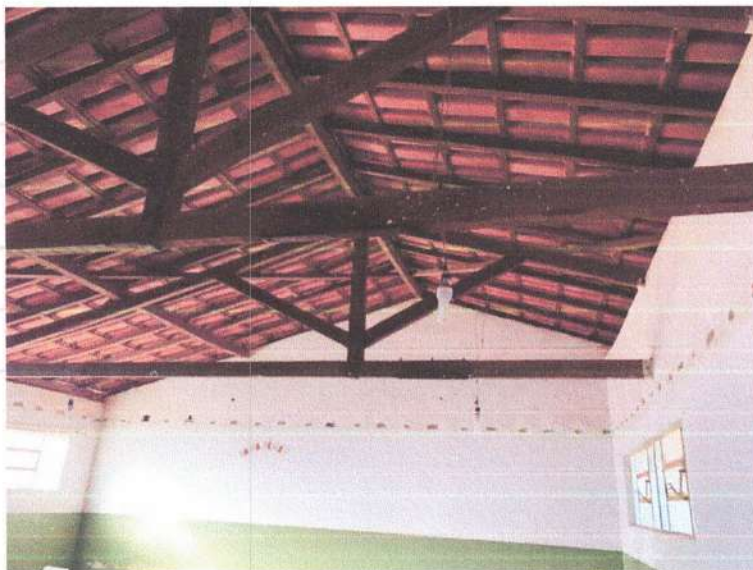
Figura 11 - Bloco 3 – Cobertura da Sala de Aula
