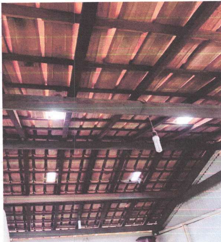
Figura 07 - Bloco 1 – Cobertura da Sala de Aula
