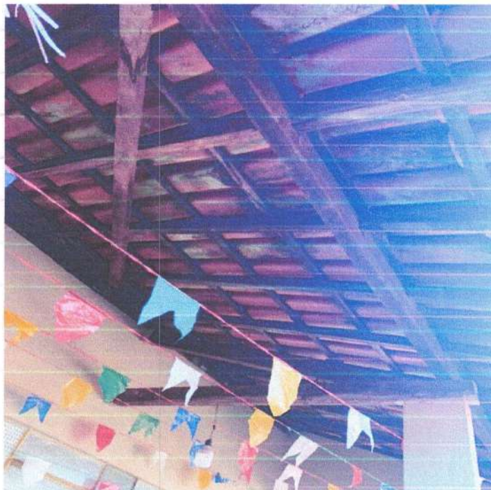
Figura 12 - Bloco 3 – Corredor entre Blocos 2 e 3
