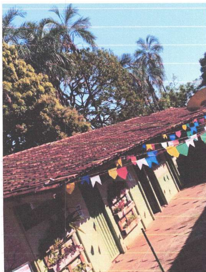
Figura 04 - Bloco 1 – Vista Lateral
