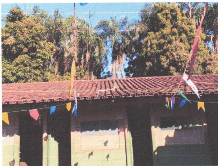
Figura 03 - Bloco 1 – Vista Lateral
