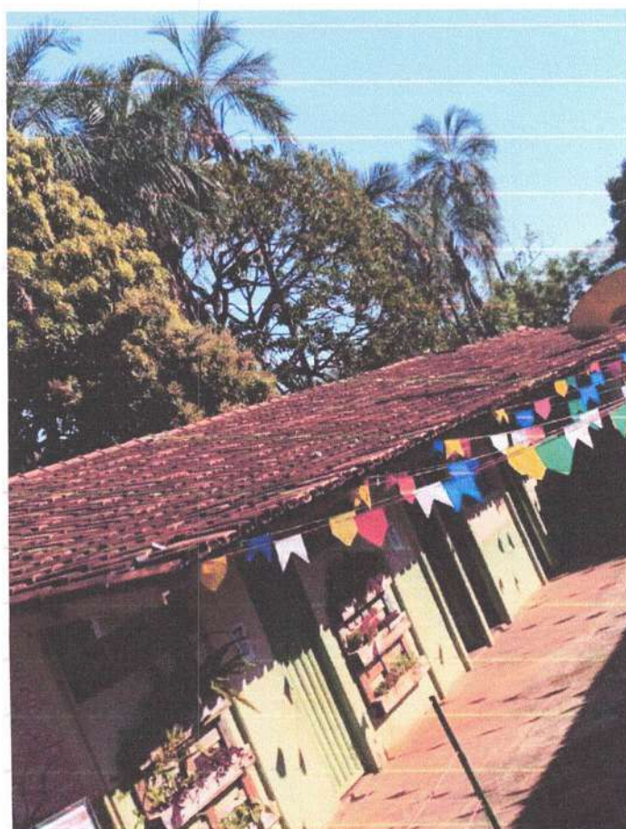
Figura 04 - Bloco 1 – Vista Lateral
