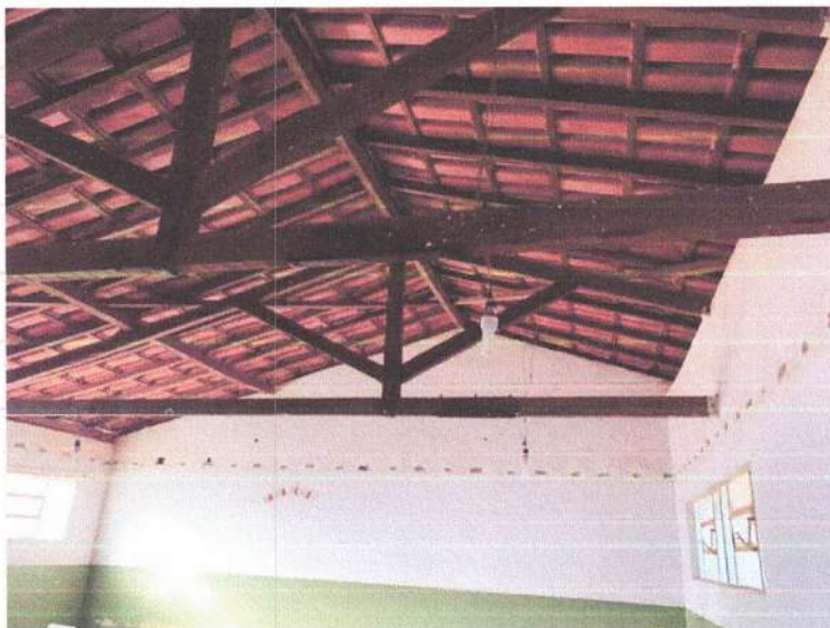
Figura 11 - Bloco 3 – Cobertura da Sala de Aula
