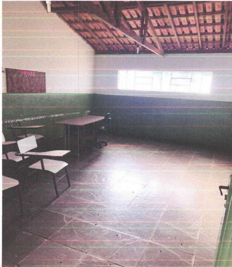
Figura 09 - Bloco 3 – Cobertura da Sala de Aula
