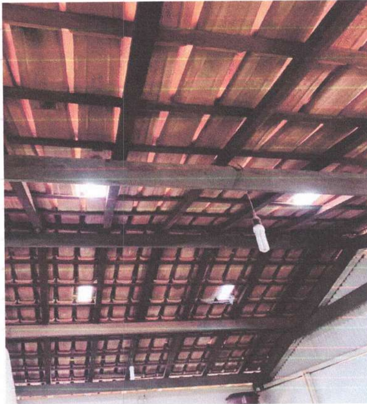
Figura 07 - Bloco 1 – Cobertura da Sala de Aula
