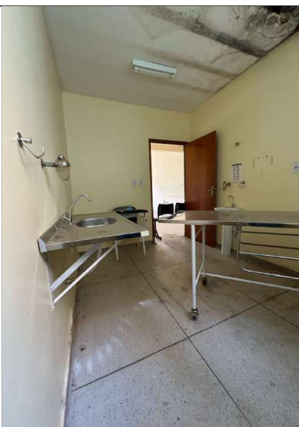
Sala de vacinas
