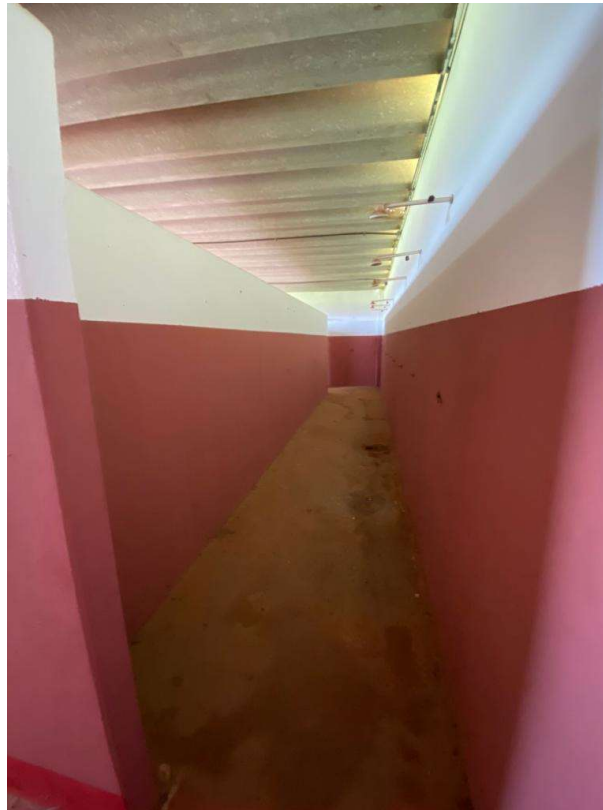
Figura 7 - Vestiário dos Jogadores (troca de chuveiros)
