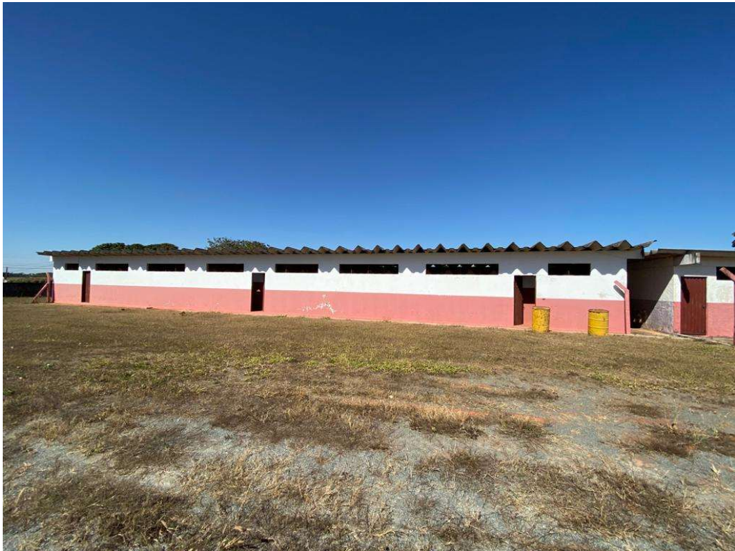
Figura 5 - Vestiários dos Jogadores (pintura esquadrias metálicas)
