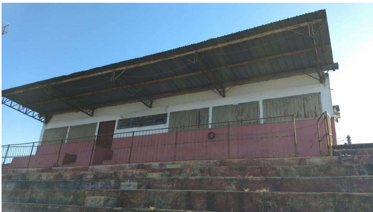
Figura 4 - Cabine (pintura esquadrias e cobertura)
