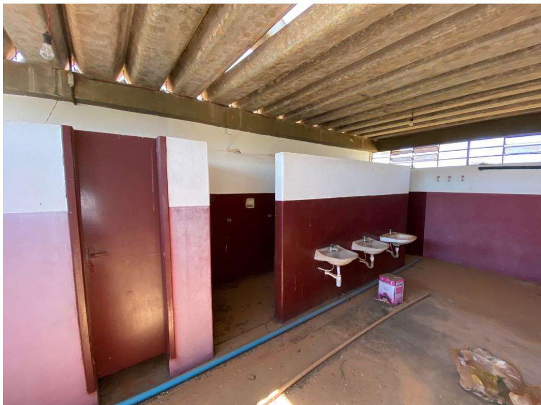
Figura 12 - Vestiário dos Árbitros (pintura esquadrias metálicas e troca de Cobertura)
