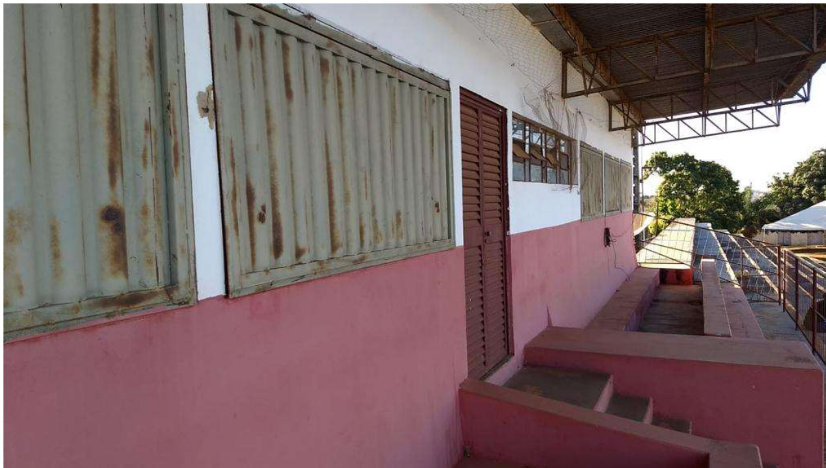
Figura 3 - Arquibancada / Cabine (pintura esquadrias e cobertura)
