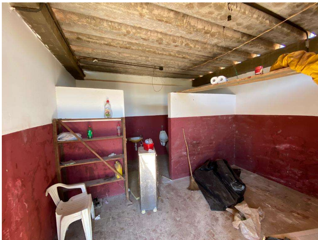
Figura 14 - Vestiário do Árbitros (troca da Cobertura)
