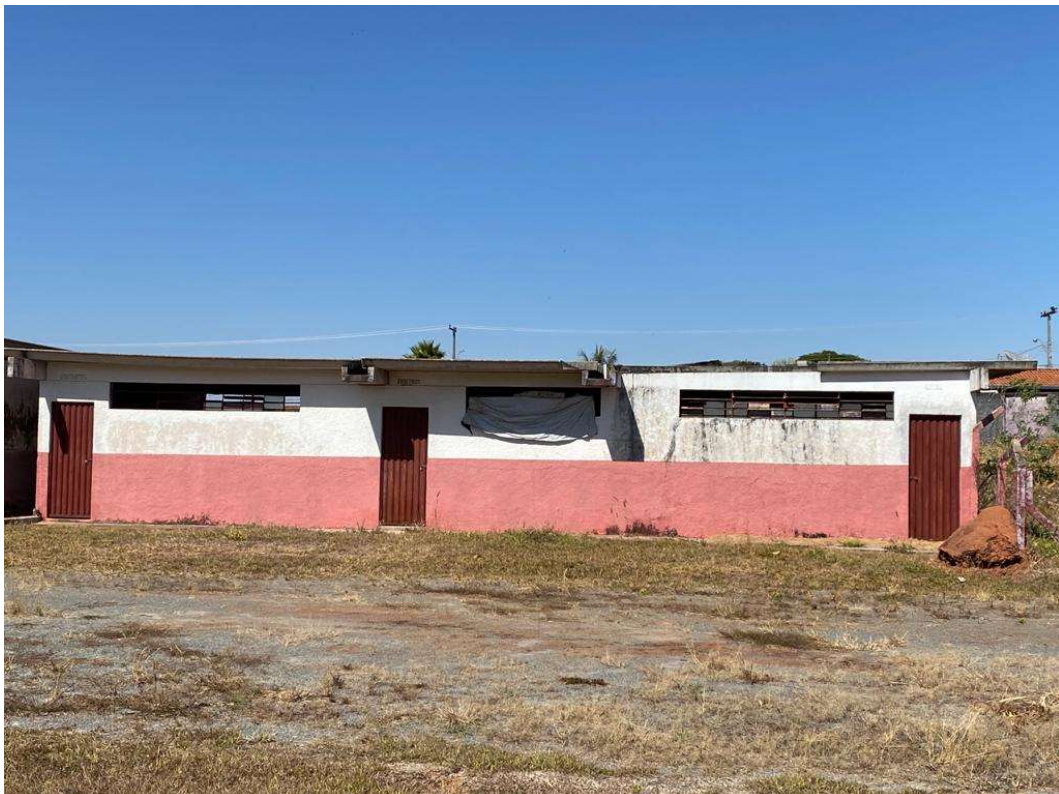
Figura 10 - Vestiários dos Árbitros (pintura esquadrias metálicas / troca da cobertura)
