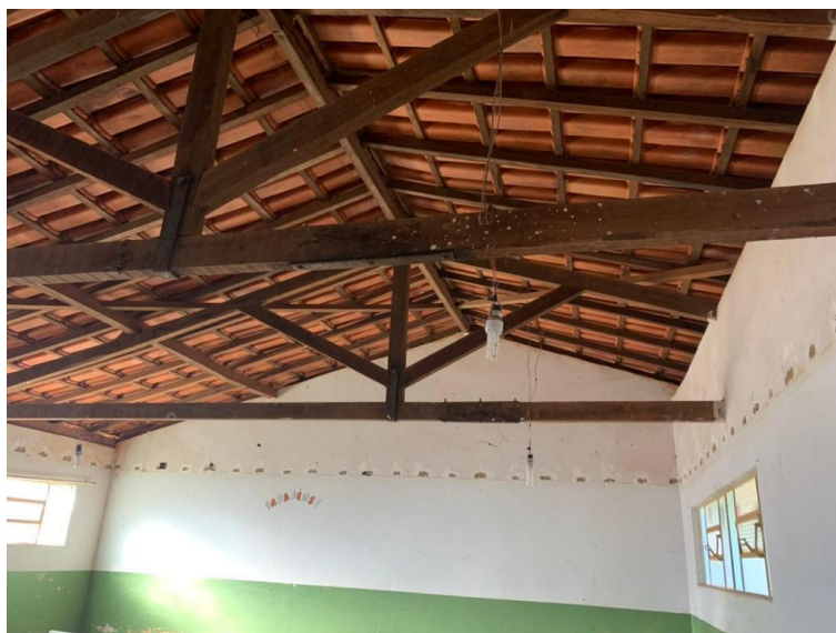
Figura 08 - Bloco 3 – Cobertura da Sala de Aula
