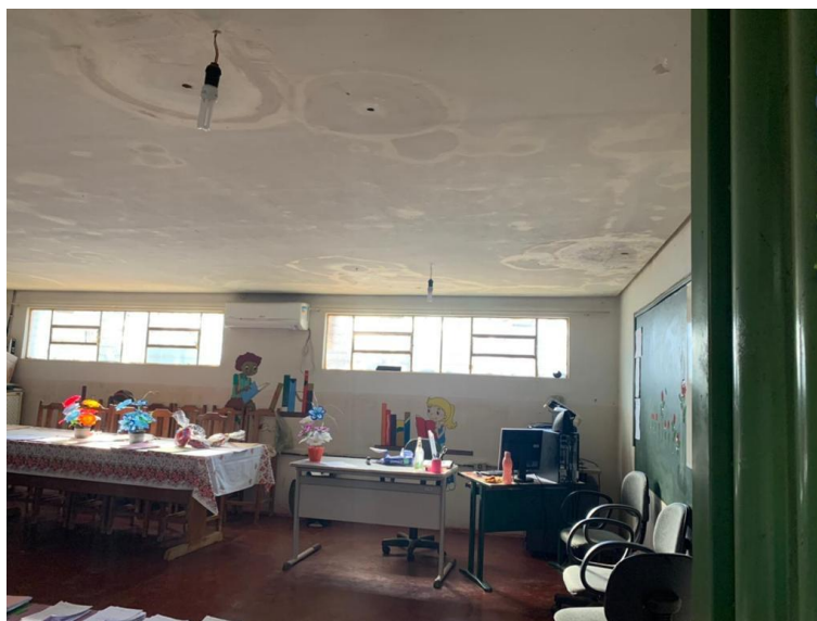
Figura 10 - Bloco 3 – Cobertura da Sala dos Professores
