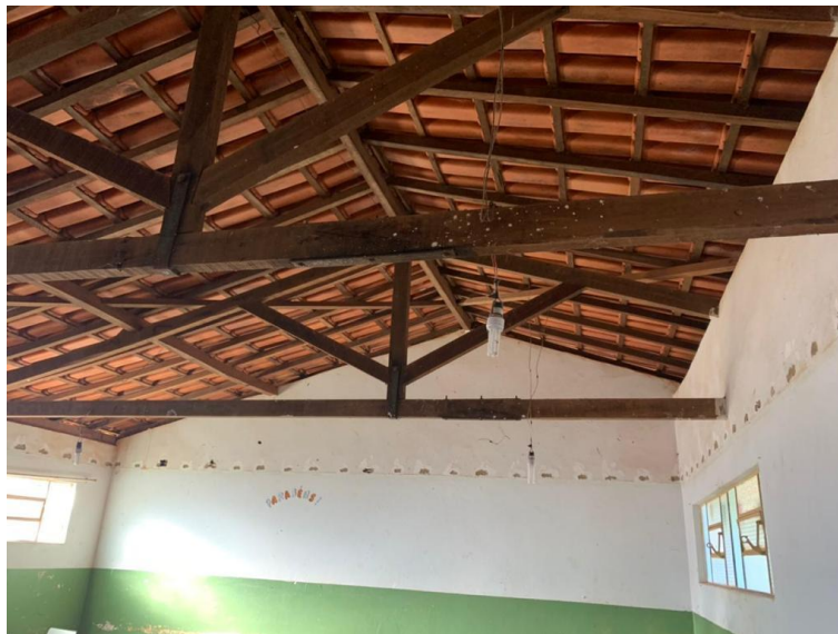
Figura 11 - Bloco 3 – Cobertura da Sala de Aula
