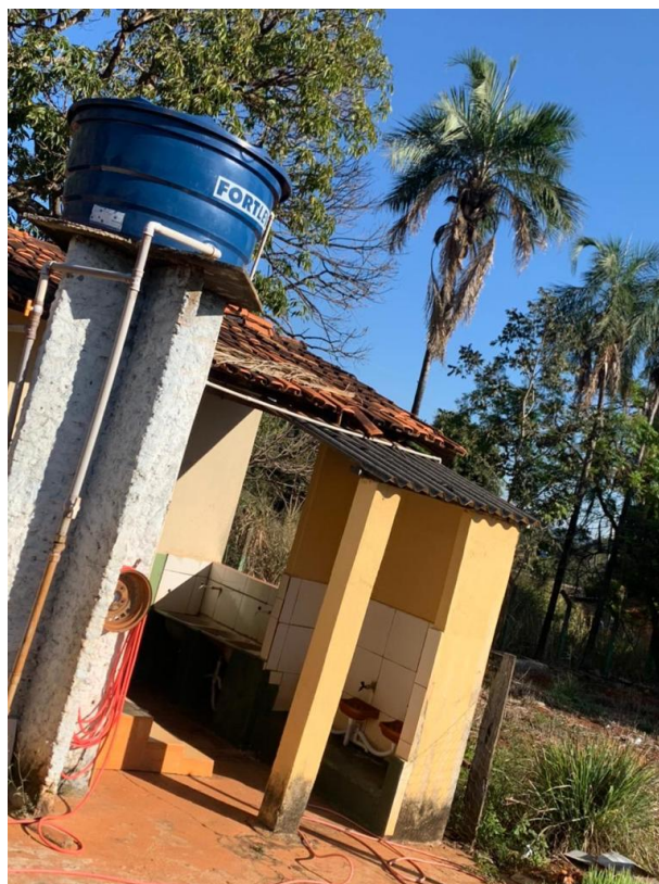
Figura 06 - Bloco 1 – Cobertura dos Sanitários
