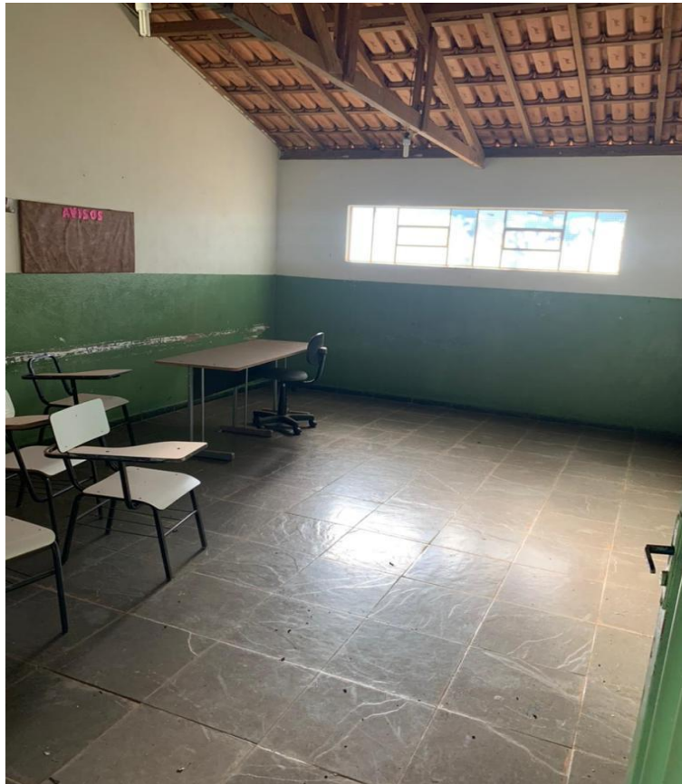
Figura 09 - Bloco 3 – Cobertura da Sala de Aula
