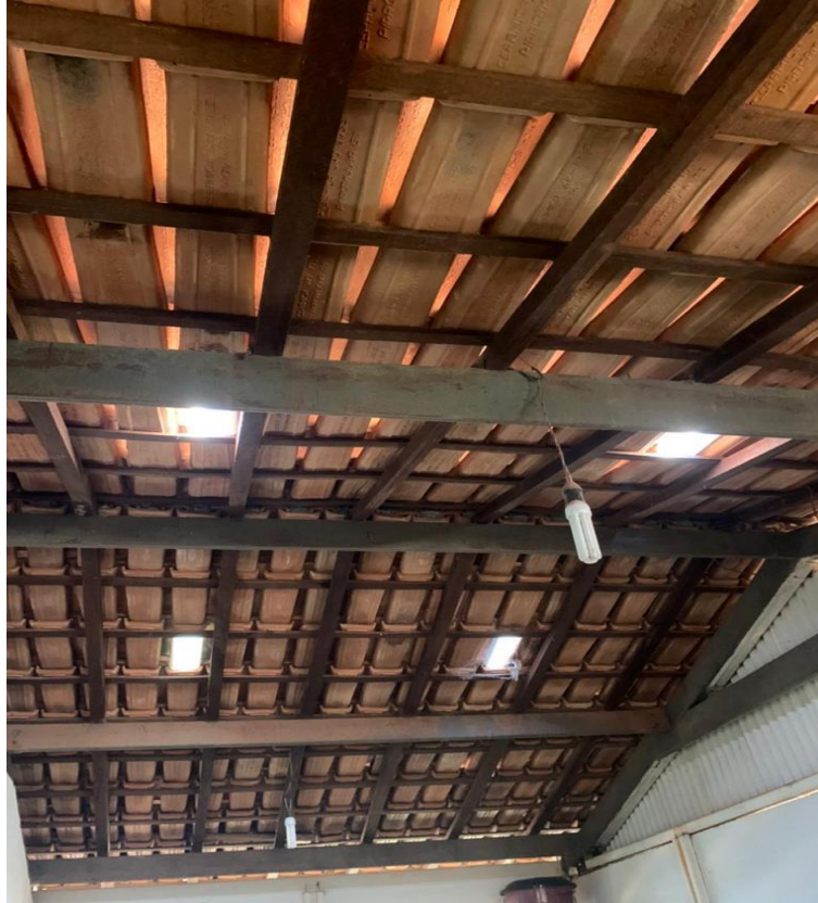
Figura 07 - Bloco 1 – Cobertura da Sala de Aula
