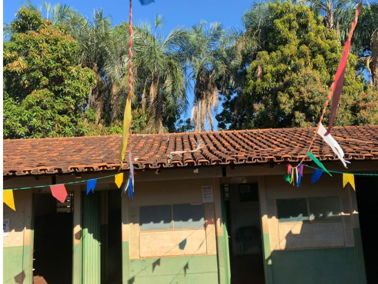
Figura 03 - Bloco 1 – Vista Lateral
