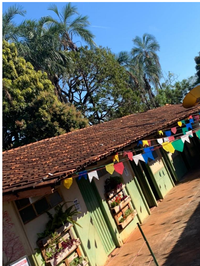
Figura 04 - Bloco 1 – Vista Lateral
