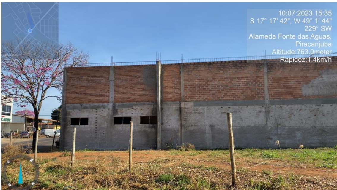
Foto 03 – Fachada Lateral Esquerda
