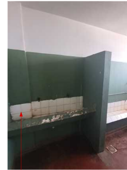
LAVATÓRIO EXISTENTE A DEMOLIR
