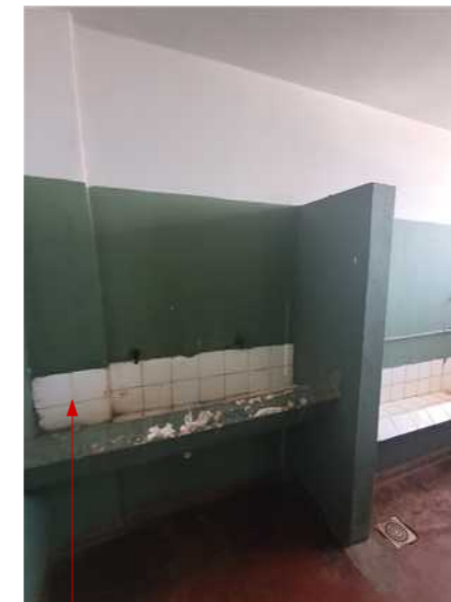
LAVATÓRIO EXISTENTE A DEMOLIR
