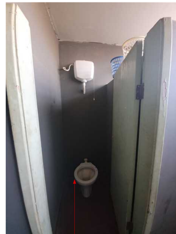
• SUBSTITUIR BACIA SANITÁRIA EXISTENTE POR BACIA SANITÁRIA COM CAIXA ACOPLADA. SUBSTITUIR PORTAS DE MADEIRA EXISTENTES POR PORTAS VENEZIANAS EM ALUMÍNIO
