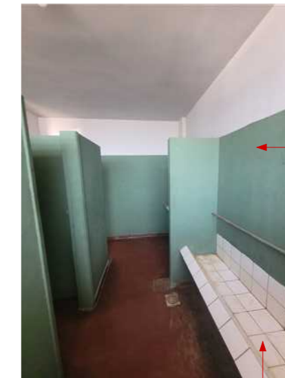
MICTÓRIO EXISTENTE A DEMOLIR
