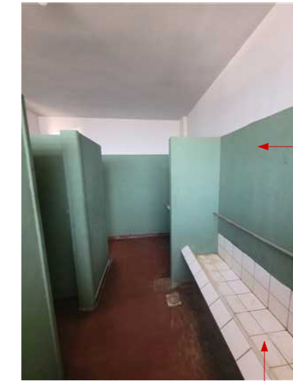
MICTÓRIO EXISTENTE A DEMOLIR
