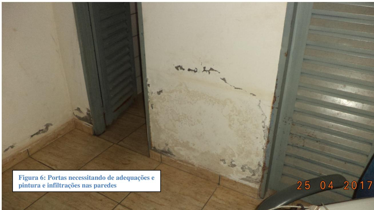
Figura 6: Portas necessitando de adequações e pintura e infiltrações nas paredes
