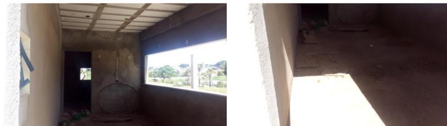
Falta revestimento das paredes e piso, louças sanitárias. Não há passagem da fiação elétrica.
