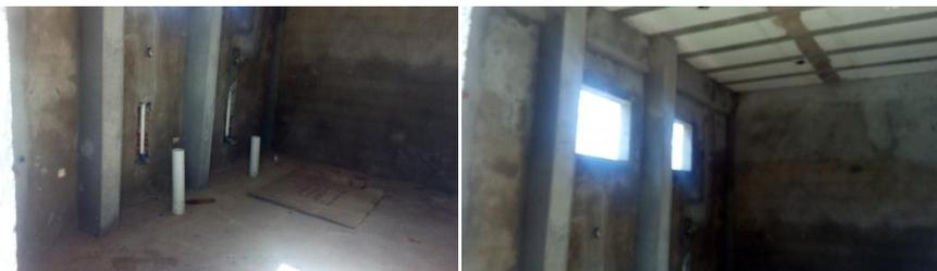
Teto sem chapisco, reboco e pintura. Paredes sem pintura e esquadrias.
